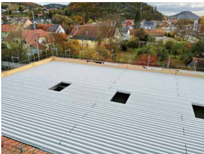
Das bereits auf die Stahl-Dachbinder als Dach verlegte Trapezblech.
