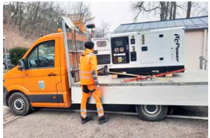
Eines der neu beschafften Stromaggregate (hier für das Rathaus Donaustauf), um für den Katastrophenfall gerüstet zu sein.
