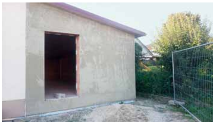
An die Nordseite des Gerätehauses wurde ein Anbau geschaffen..
