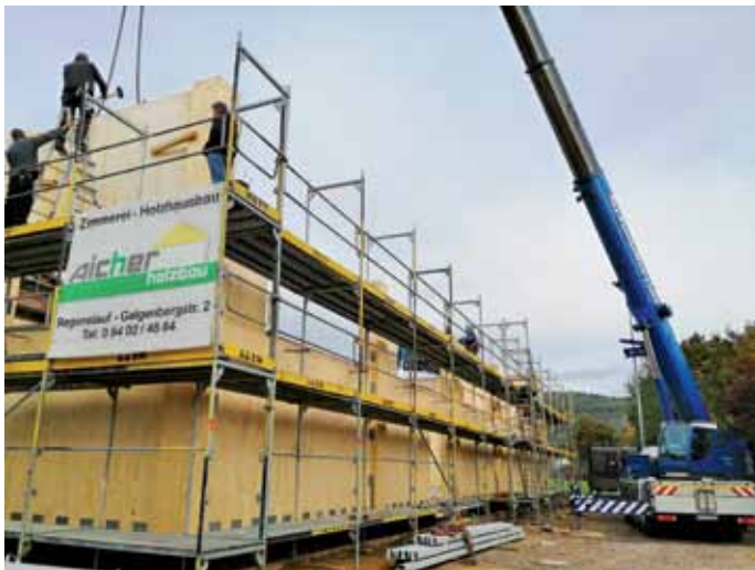
Der Anbau an die Halle wird in Holzbauweise mit einer Stahlkonstruktion erstellt.
