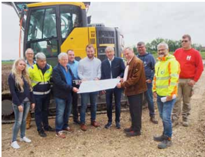
Ein Bild von den Erschließungsarbeiten im Baugebiet Frengkofen-Ost machten sich Bürgermeister Thomas Schmalzl (5.v.r.) und die Vertreter der Gemeinde und Verwaltung. (Foto: Peter Luft)
