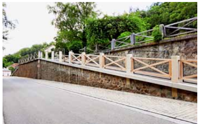
Die sanierte Auffahrtsrampe an der Wörther Straße.
