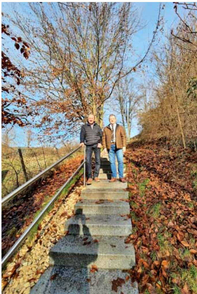
Die sanierte Treppe in der Kantstraße. Somit ist die Querverbindung zwischen Prüllstraße und Oberem Markt wieder sicherer möglich.
