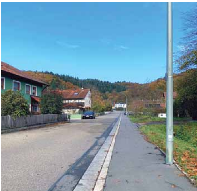
Der erneuerte Bürgersteig in der Karlstraße
